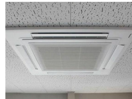
空調設備更新
