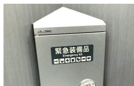
エレベーター内防災キャビネットの設置
