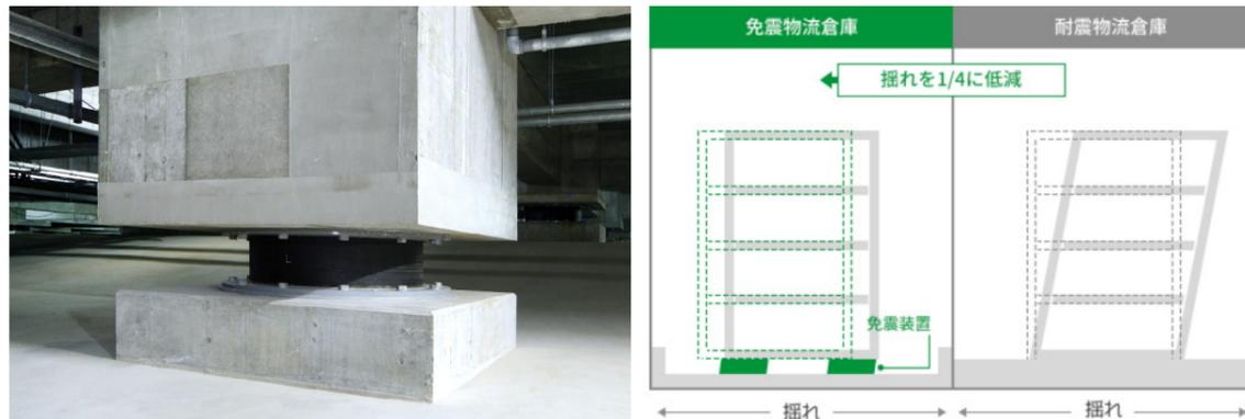
大地震においても機能を発揮する独自の免震構造システム「GLPパイルキャップ免震工法(特許番号4934769号)」を開発し、32物件で採用しています。また2015年には、さらに合理的な設計を実現する、独自の免震構造解析手法「GLP同時刻歴一体応答解析手法(特許番号5698402)」を新たに開発・採用しています。
