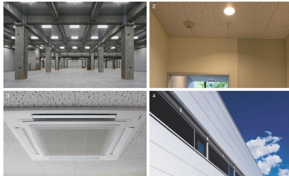
物流施設の照明LED化をはじめ人感センサーの採用、倉庫部分の点滅区分の設定などにより、施設内のエネルギー使用量の削減を推進しています。また、施設の空調設備更新による省エネ推進のほか、外壁には、建物断熱性能を向上させる断熱パネルを採用するなど、建物内のエネルギー効率を高めています。
